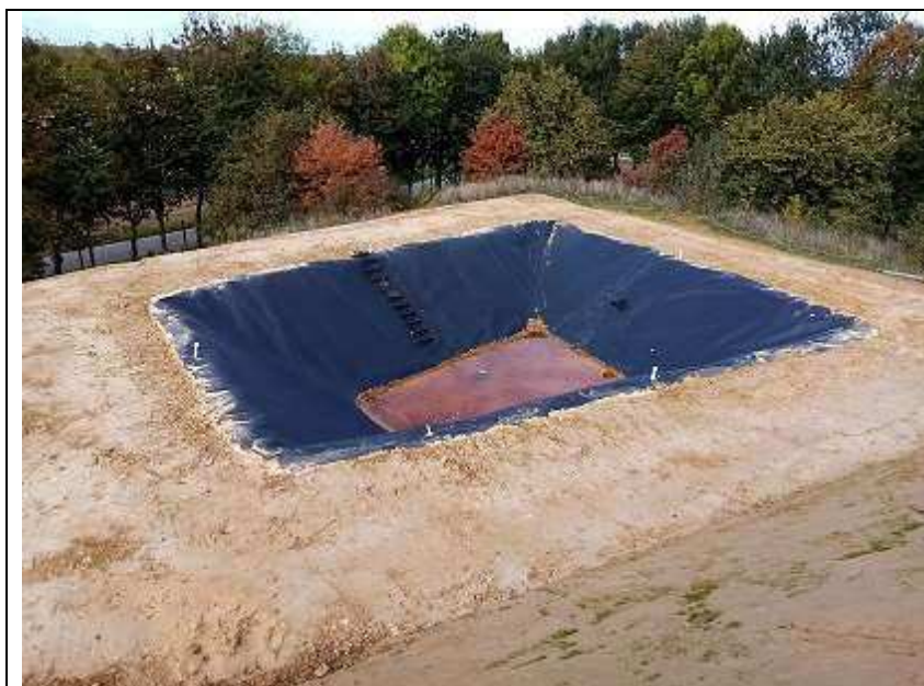
Photo fin de travaux d'étanchéité
